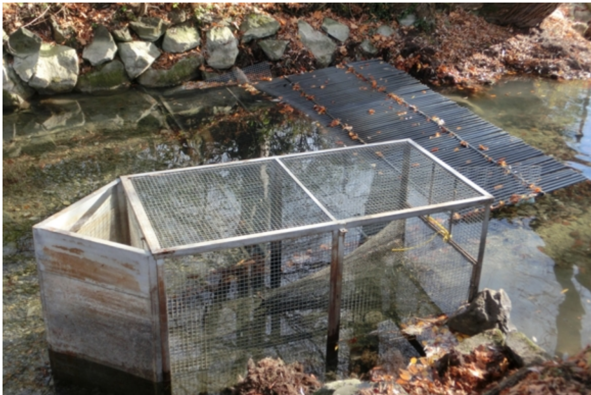
Reusenkasten und dynamisches Fischwehr zur Kontrolle des Seeforelleneinstieges in den Georgenbach
